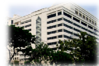
อาคารจอดรถ 2
