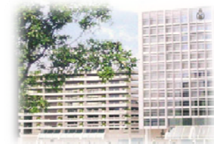
อาคารจอดรถ 3
