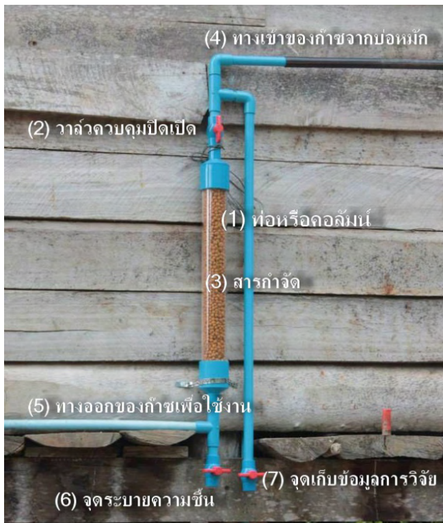
ภาพ 10 ชุดกำจัดก๊าซไฮโดรเจนซัลไฟด์ในก๊าซชีวภาพ
