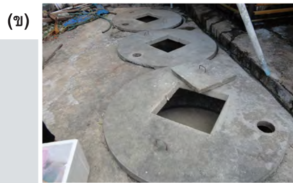
ภาพที่ 2 บ่อพักน้ำทิ้งที่ออกจากโรงงานผลิตเส้นขนมจีน (ก) บ่อพักน้ำทิ้งจุดแรก มีลักษณะเป็นท่อซีเมนต์เดี่ยว (ข) บ่อพักน้ำทิ้งจุดที่ 2 เป็นบ่อพักน้ำทิ้งรวมทั้งหมด
