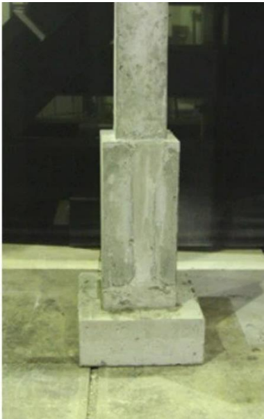
เทคอนกรีตหุ้มเสา
