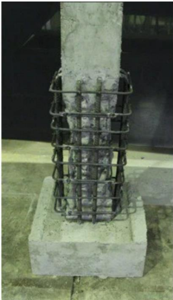
เสริมเหล็กแกน และเหล็กปลอก
